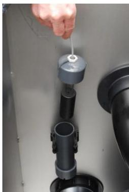
Рисунок 2: Датчик S – версии, установка в нижней биованне
